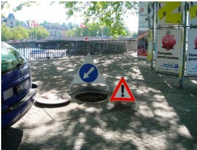
Der als Kanaldeckel getarnte Einstieg in den Bunker lässt sich mit Spezialschlüsseln öffnen. Zwei weitere Deckel in nächster Nähe dienen als Notausgang und als Zugang zum Schlaufkasten des Sprengobjektes.
