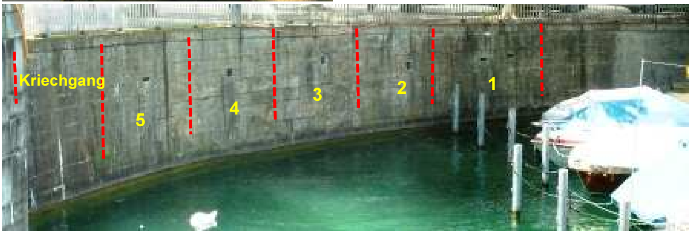
Blickt man von der Quaibrücke auf die Quaimauer entlang des Stadthausquais, lassen sich die einzelnen Scharten sehr gut erkennen. Zur besseren Übersicht sind auf dem oberen Bild die ungefähren Abschnitte der einzelnen Räume eingezeichnet, sie sind identisch mit den Nummern auf der obigen Skizze. Kampfraum 1 mit einer Scharte für 1 Maschinengewehr (Mg) rechts davon eine Beobachterscharte. Kampfraum 2, 3 und 4 mit je einer Scharte für 1 leichtes Maschinengewehr (LMg). Kampfraum 5 mit einer Scharte für 1 Maschinengewehr (Mg) rechts davon eine Beobachterscharte. Hier im Bild ist nur die Beobachterscharte erkennbar, die Mg-Scharte linkerhand ist verdeckt. Im Kriechgang und im Bereich des Holzsteges befinden sich keine Scharten. Im Raum 4 befindet sich auch eine Zündstelle, von wo aus die Quaibrücke (Sprengobjekt) hätte gesprengt werden können.
