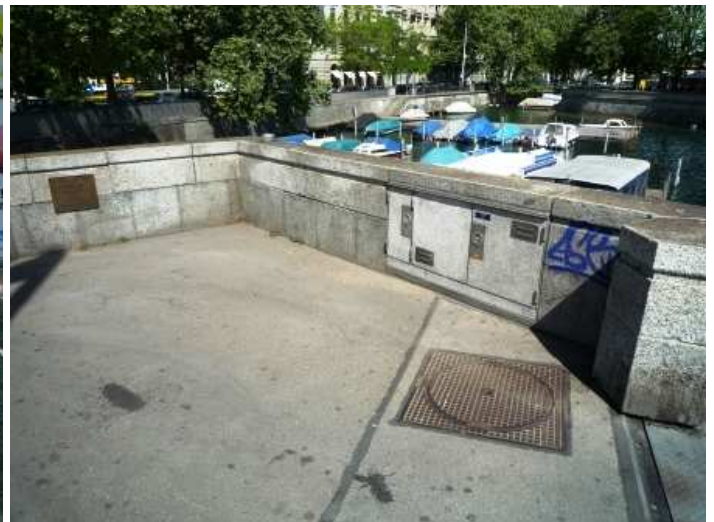
Der als Kanaldeckel getarnte Einstieg in den Bunker lässt sich mit Spezialschlüsseln öffnen. Zwei weitere Deckel in nächster Nähe dienen als Notausgang und als Zugang zum Schlaufkasten des Sprengobjektes.
