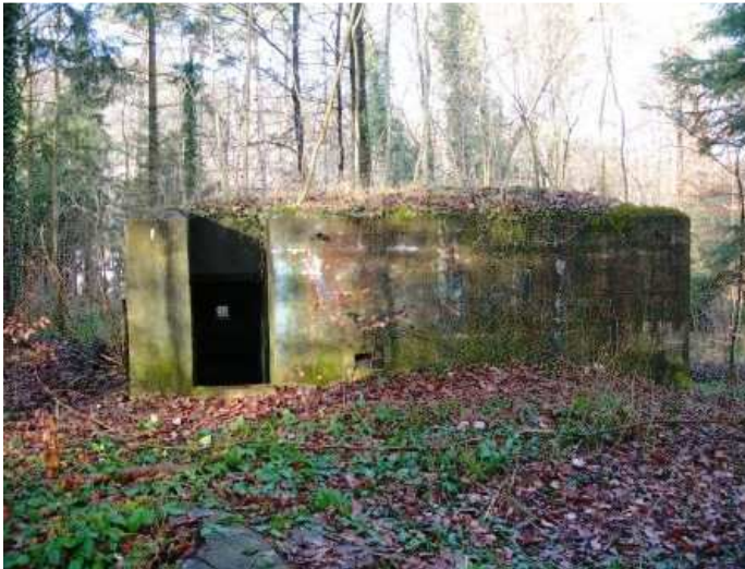
Der Zugangsbereich mit abgewinkelttem Korridor und der darin integrierten Schiessöffnung für ein LMg.
