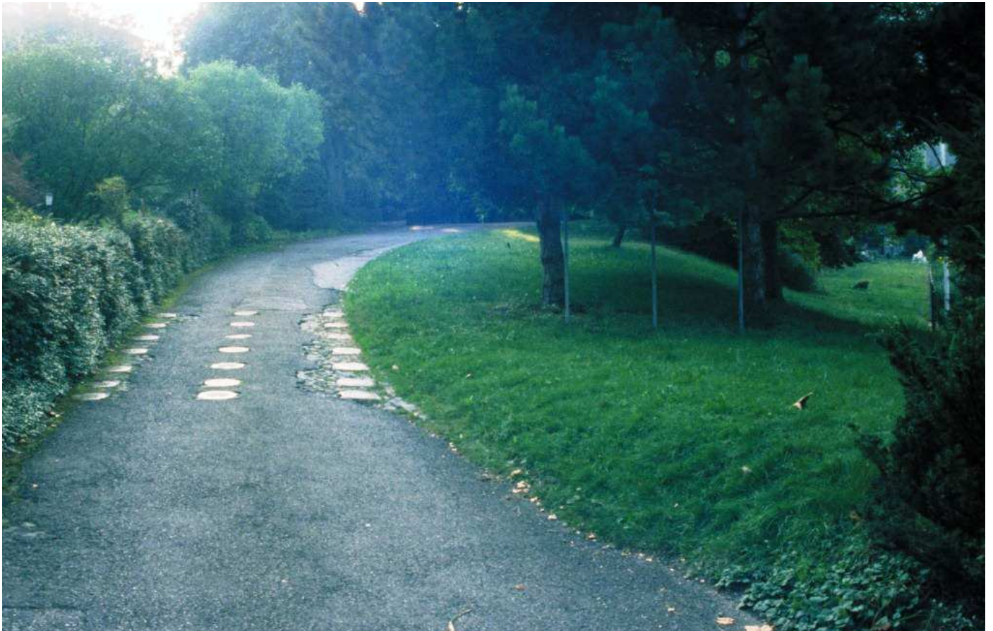
Historische Ansicht der ehemaligen Tankbarrikade Zwirnerstrasse. Schön erkennbar sind die 21 Deckel der Schächte zum Einlegen der Steckelemente. Bild: Denkmalpflege Kanton Zürich
