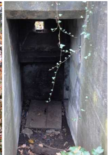
Der Zugangsbereich mit abgewinkelttem Korridor und der darin integrierten Schiessöffnung für ein LMg.
