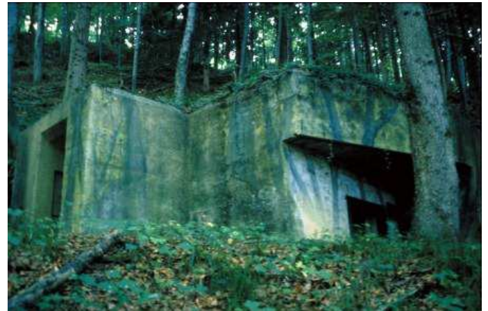
Ansicht der ursprünglichen Tarnbemalung Bild: Denkmalpflege Kanton Zürich
