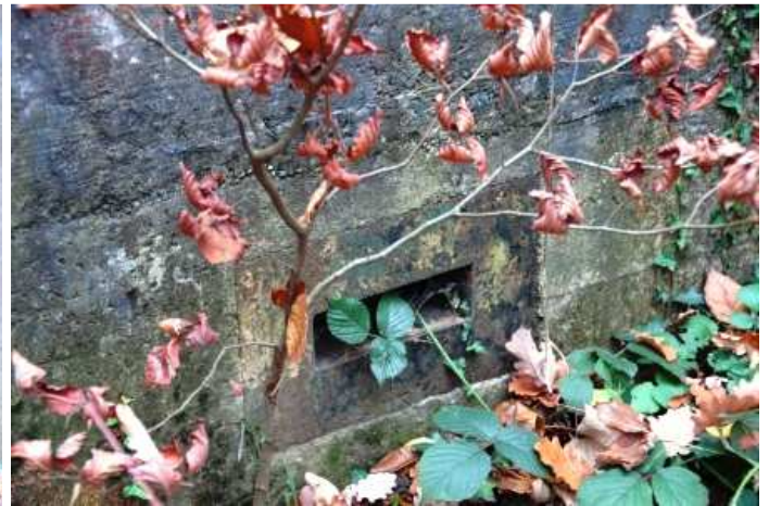
Feldmässige Stufenscharte geschützt durch ein beidseitiges Flankenschild. Sehr schön erkennbar die teilweise noch vorhandene Tarnbemalung. Die Beobachterscharte wird von der Natur eingenommen.
