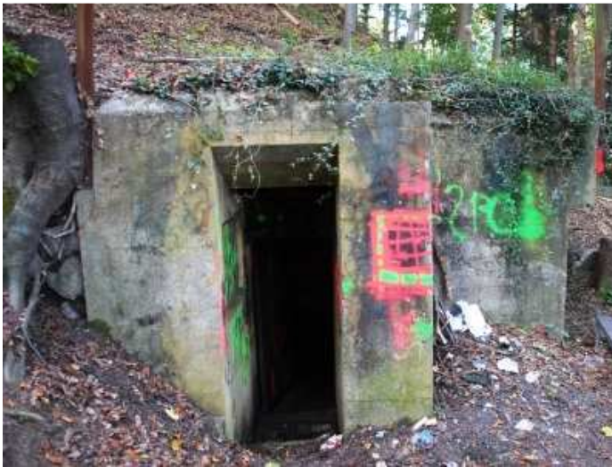
Zugangsbereich und rechts davon die Scharte mit einem seitlich angebrachten Flankenschild als Schutz.
