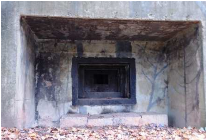
Feldmässige Stufenscharte geschützt durch ein beidseitiges Flankenschild. Sehr schön erkennbar die teilweise noch vorhandene Tarnbemalung. Die Beobachterscharte wird von der Natur eingenommen.
