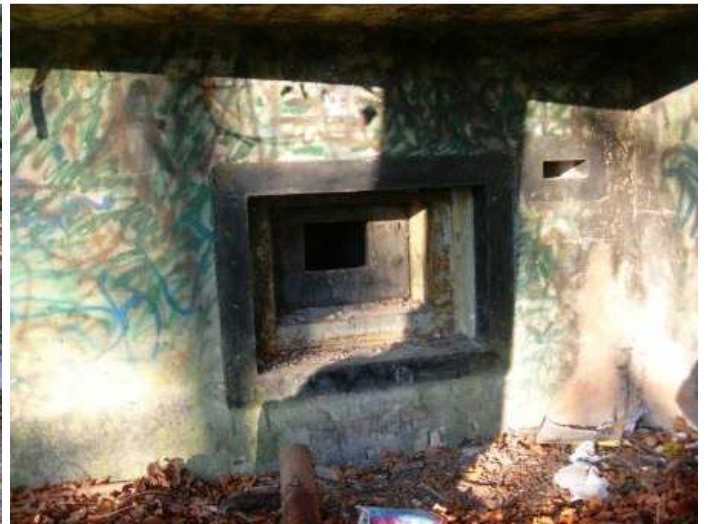
Zugangsbereich und rechts davon die Scharte mit einem seitlich angebrachten Flankenschild als Schutz.
