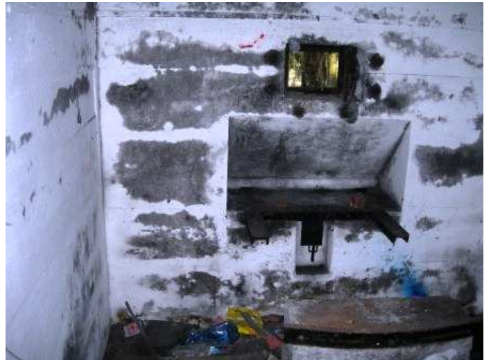
Der Zugangsbereich mit abgewinkelttem Korridor und der darin integrierten Schiessöffnung für ein LMg.
