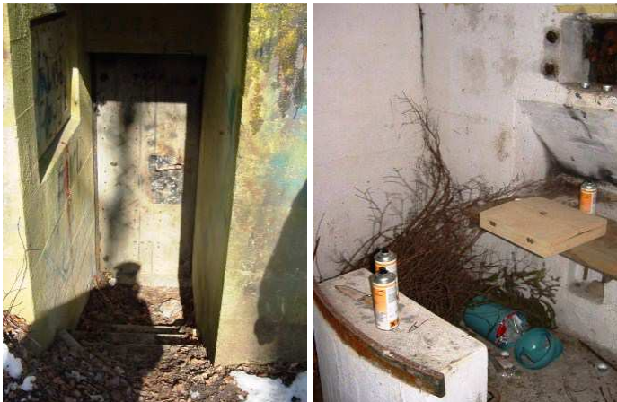
Zugangsbereich mit der grossen Inschriftentafel und ein Blick in das Innere mit Betonsockel für eine Feldlafette.
