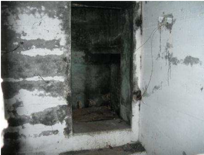
Der Zugangsbereich mit abgewinkelttem Korridor und der darin integrierten Schiessöffnung für ein LMg.
