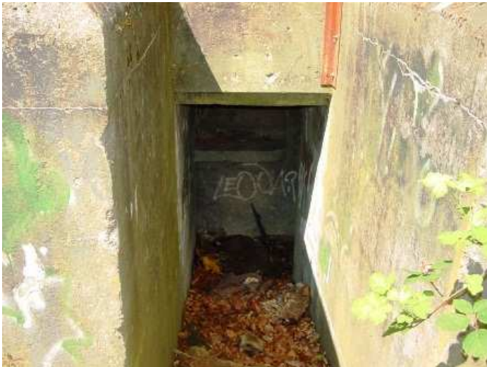
Treppenabgang zum gedeckten Vorraum mit LMg-Scharte in westlicher Richtung, Türe zum Kampfraum.
