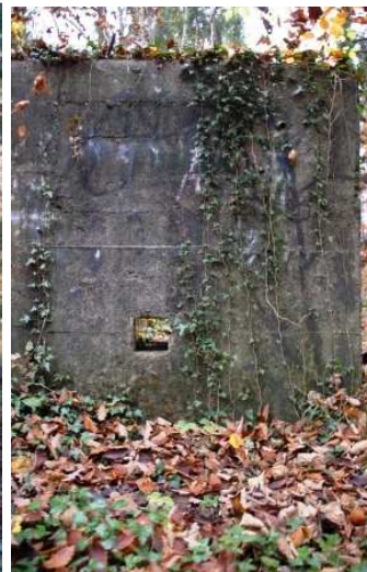
Der Zugangsbereich mit abgewinkelttem Korridor und der darin integrierten Schiessöffnung für ein LMg.
