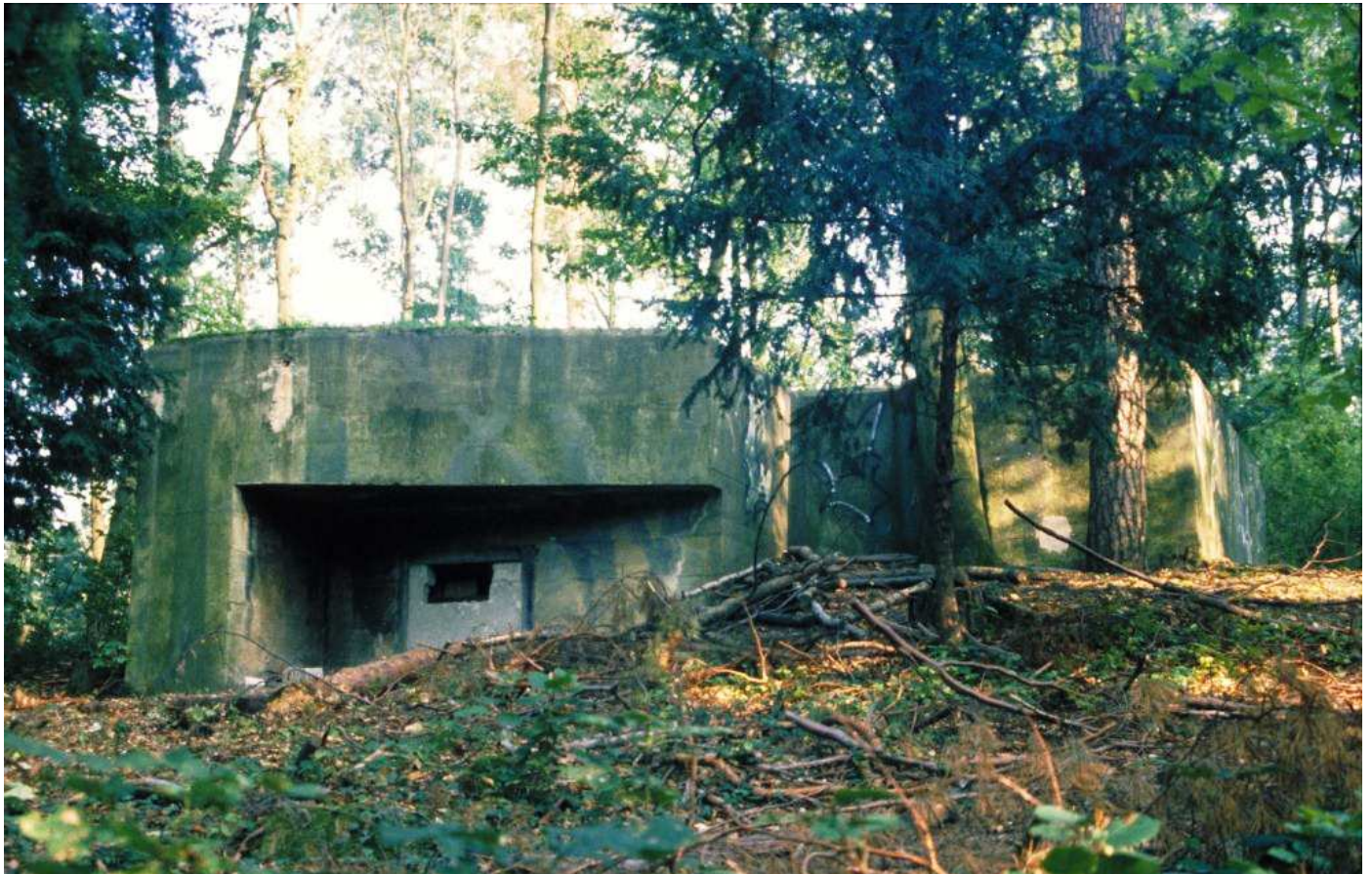
Schartenpartie mit dem ehemaligen Tarnanstrich in Richtung Gstalderweg. Der Zugang zur Anlage befindet sich auf der uns abgewandten Längsseite. Bild: Denkmalpflege Kanton Zürich
